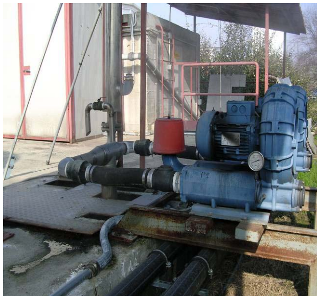
Pompe di sollevamento iniziali. Turbine di ossigenazione della vasca di equalizzazione.
