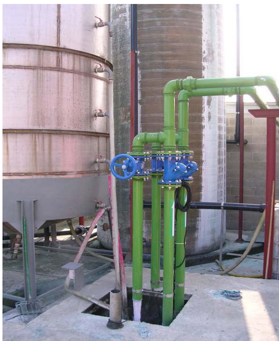
Pompe di sollevamento iniziali. Turbine di ossigenazione della vasca di equalizzazione.
