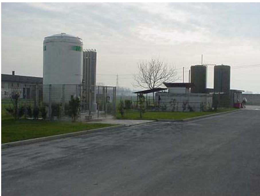
Complessivo dell'impianto di trattamento delle acque reflue
