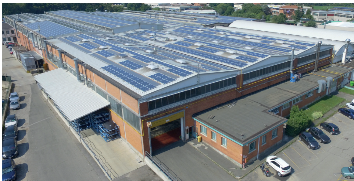
Stabilimento Cornaglia - Impianti fotovoltaici
